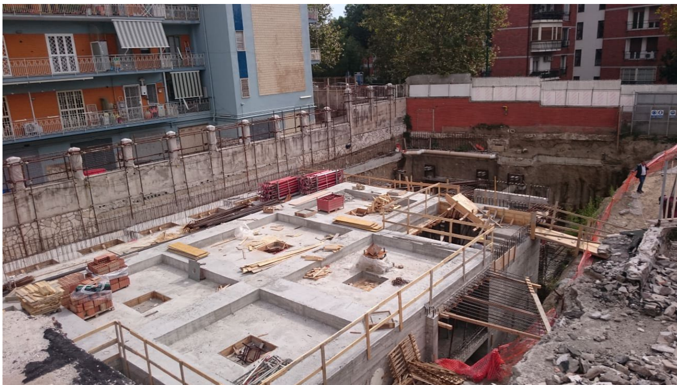
Figura 2: Impalcato a quota isolatori corpo A
